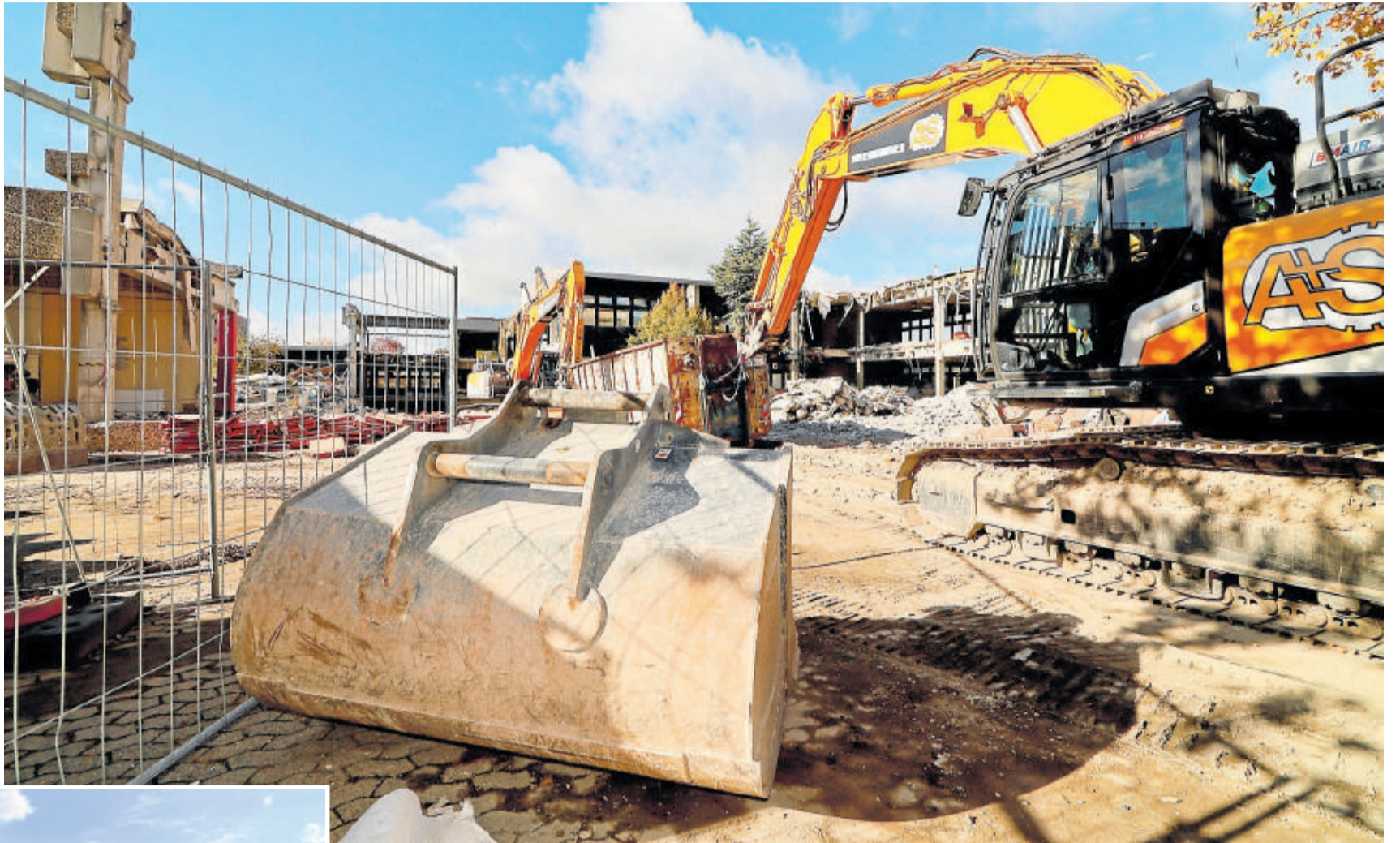
Schaufel gegen Schule: Die Bagger reißen die alte Goldene Aue gnadenlos nieder. Kleines Bild: Nostalgie: Ende Juni lässt sich das alte Schild mit den Schulnamen über dem Eingang vom Parkplatz noch von der Abendsonne bescheinen. Fotos: Epping (4), Heine (1)
