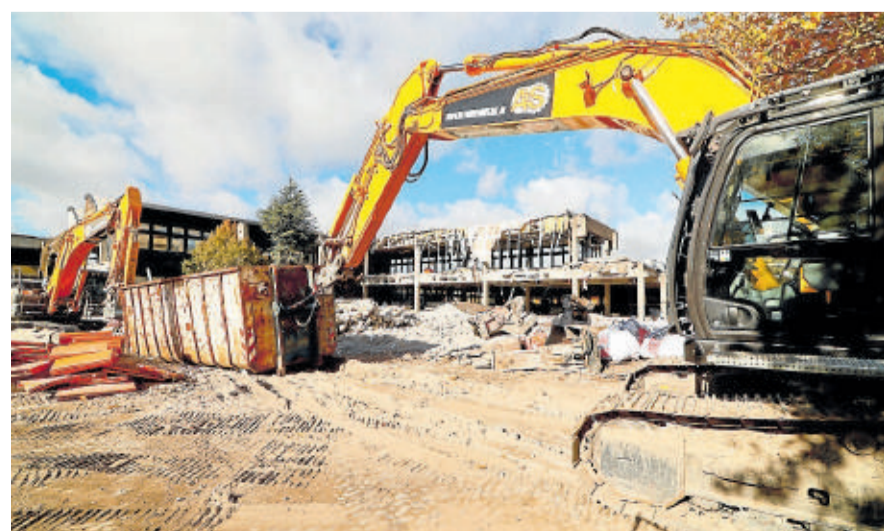
Bagger marsch: Die alte Goldene Aue, in den 1970er Jahren in mehreren Etappen hochgezogen, wird vom schweren Gerät dem Erdboden gleichgemacht. Foto: Epping
