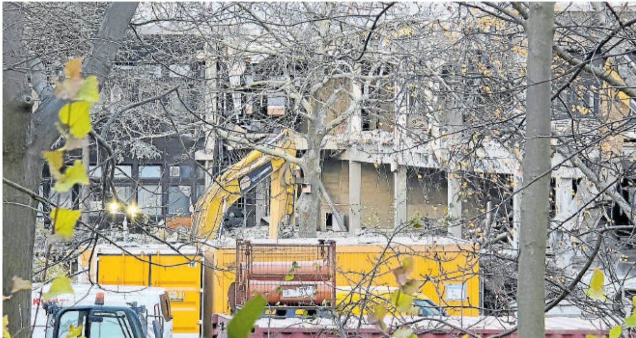
Im Zeitplan: Die alte Goldene Aue wird derzeit abgerissen. Im Sommer 2025 geht das umgestaltete Areal zurück an den Landkreis. Foto: Sowa
